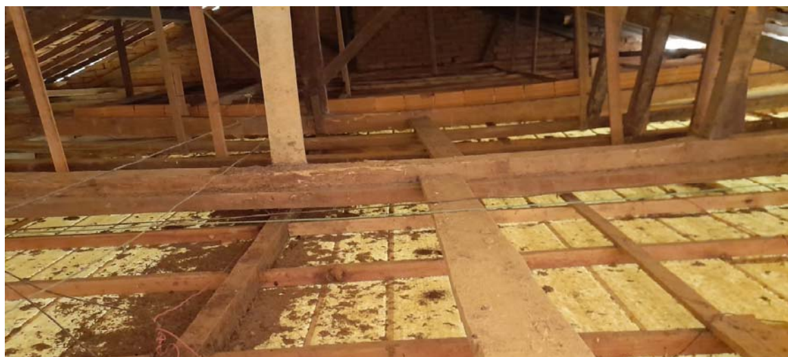
Fotos situação atual.
