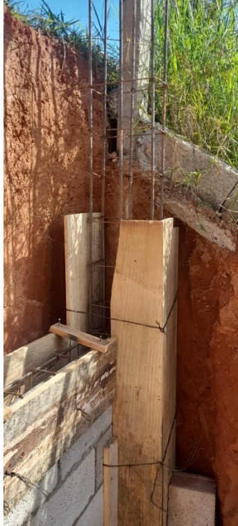
Estrutura de concreto armado pilares e cintas intermediárias
