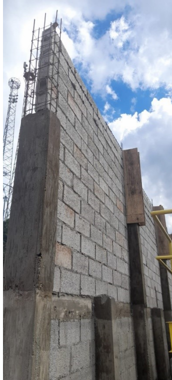
Estrutura interna alvenarias de contenção e fechamento
