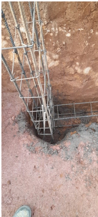
Execução de brocas e viga baldrame para fundação
