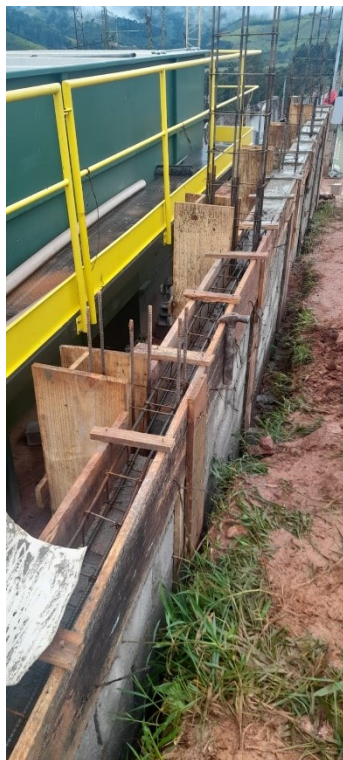
Concretagem de pilares e cintas intermediárias
