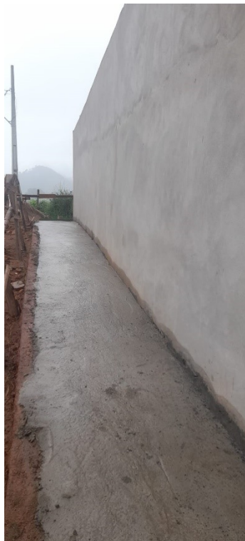
Execução lastro de concreto em pisos – calçada externa e circulação interna
