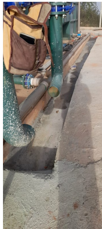
Execução de caixas e grelha para drenagem pluvial
