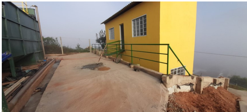
Colocação guarda-corpo tubo galvanizado
