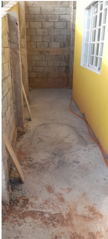
Concretagem pisos inferiores – Casa de química
