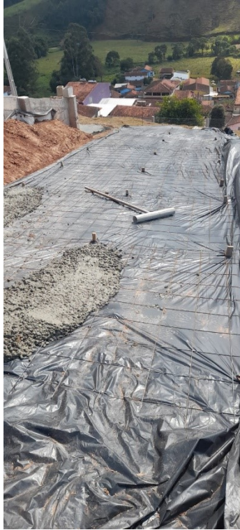
Armadura de aço e Concretagem piso rampa de acesso
