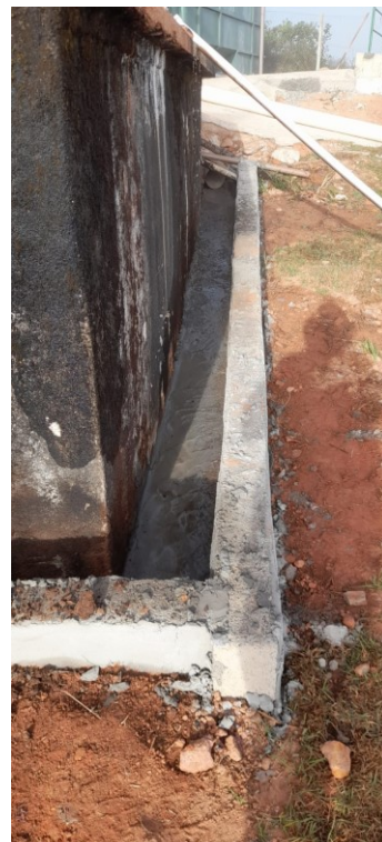
Execução de contenção e concretagem no entorno reservatório existente
