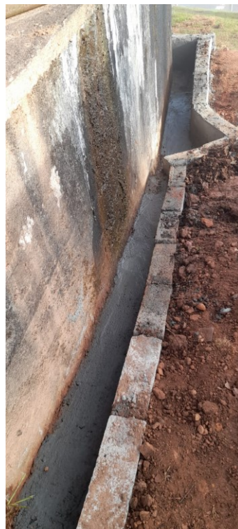
Execução de contenção e concretagem no entorno reservatório existente
