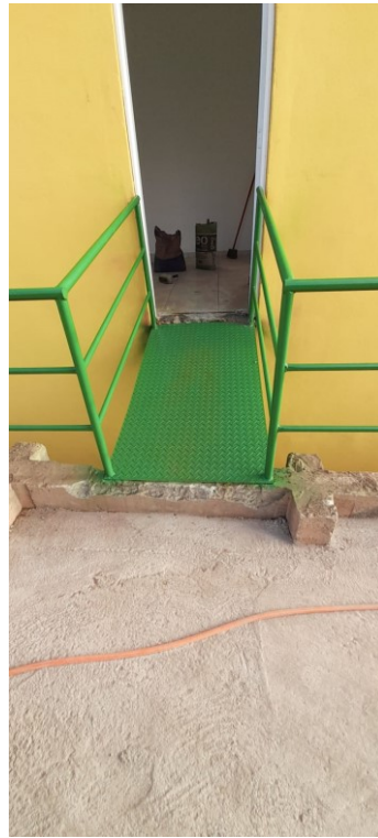
Colocação de portão e passarela chapa metálica
