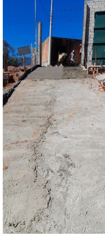
Armadura de aço e Concretagem piso rampa de acesso
