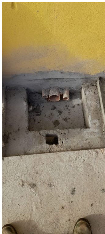
Execução de caixas e grelha para drenagem pluvial
