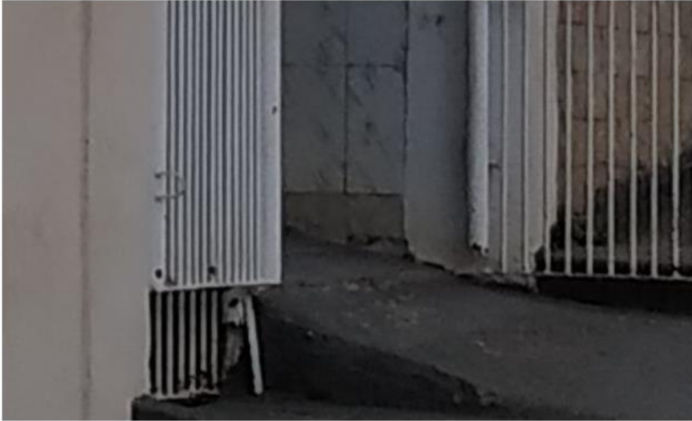
Vista portão a ser substituído
