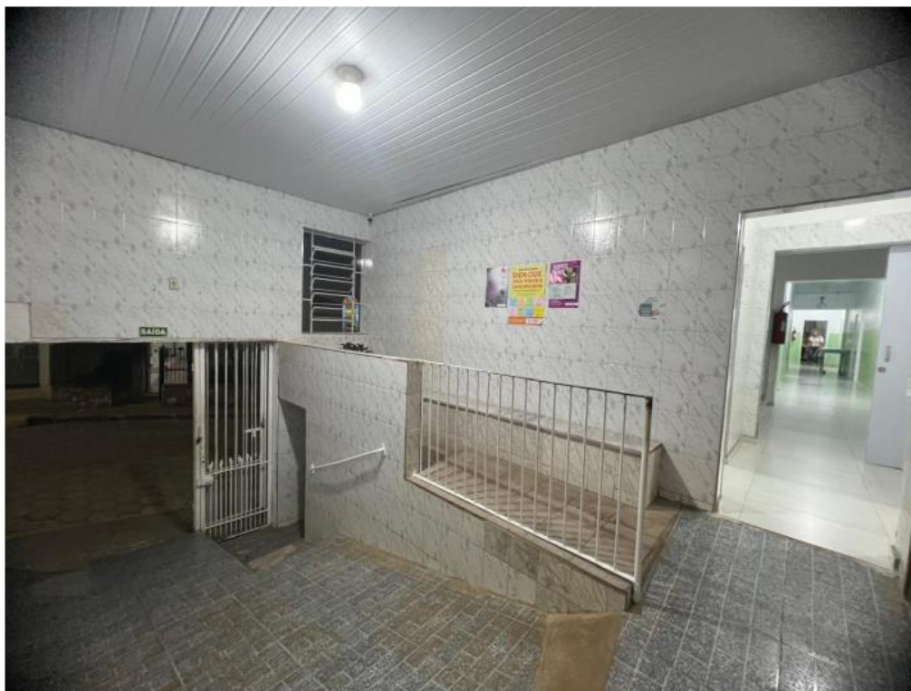
Vista 2 – Rampa de Acesso
