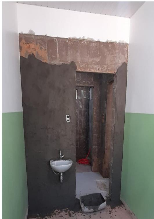
Execução de alvenarias e requadros de vãos.
