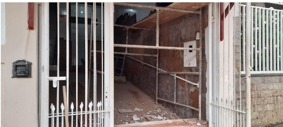
Demolições de pisos e revestimentos cerâmico rampa e recepção
