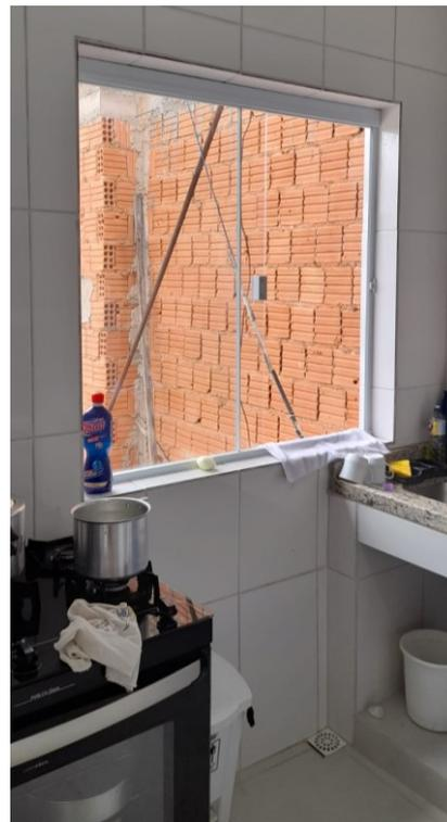
Execução revestimentos cerâmicos e requadro de janela cozinha
